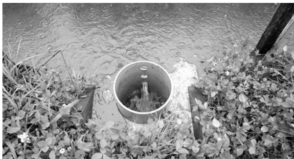
大堤（和味地区）の田んぼダム
